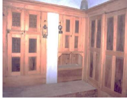
Şekil 39. ve Şekil 40. Tip oda düzenlemesinde Raflar ve İç mekanda Ahşap Gömme Duvarlar
