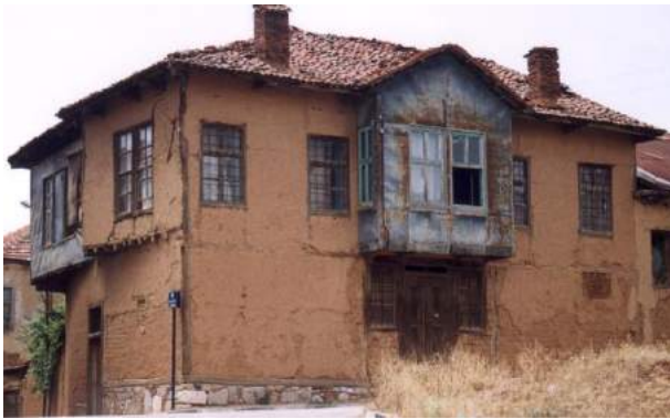
Şekil 22. ve Şekil 23. Cephede Çıkmalar ve Çinko Kaplama (M.Yeğin Arşivi)
