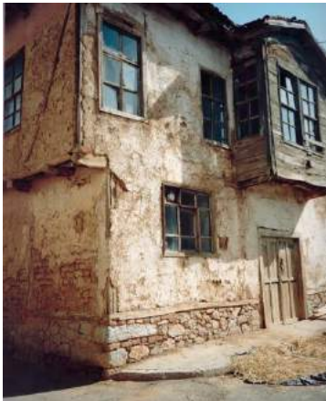
Şekil 16. ve Şekil 17. Taş Duvar ve Kerpiç Dolgulu Ahşap İskelet Sistem (M. Yeğin Arşivi)
