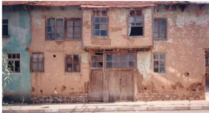
Şekil 16. ve Şekil 17. Taş Duvar ve Kerpiç Dolgulu Ahşap İskelet Sistem (M. Yeğin Arşivi)
