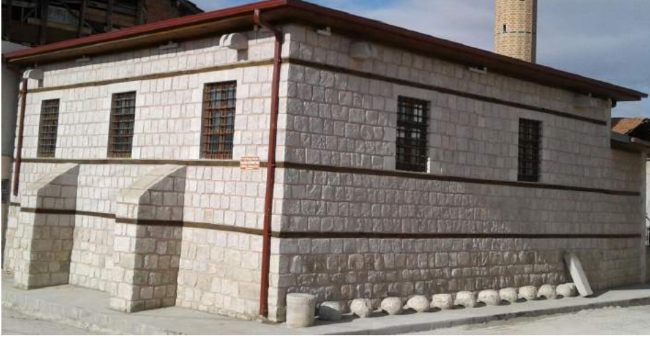
Toptaş Camisinin sol cephesinde yer alan Misafir taşları.
