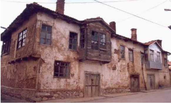
Şekil 14. Kaş Mah. Kasap Sok. No:2-4 Çıkmalar ve Duvar sistemi (M. Yeğin Arşivi)
