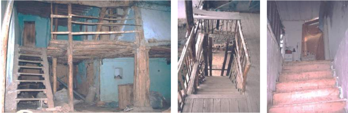
Şekil 28. ve Şekil 29. Hanayda Limon Kirişli Merdiven ve Korkuluğu (M.Yeğin Arşivi)
