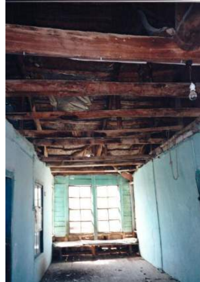
Şekil 26. ve Şekil 27. Çatı Sistemi Baçalar ve İç Mekan Tavan Döşemesi (M. Yeğin)
