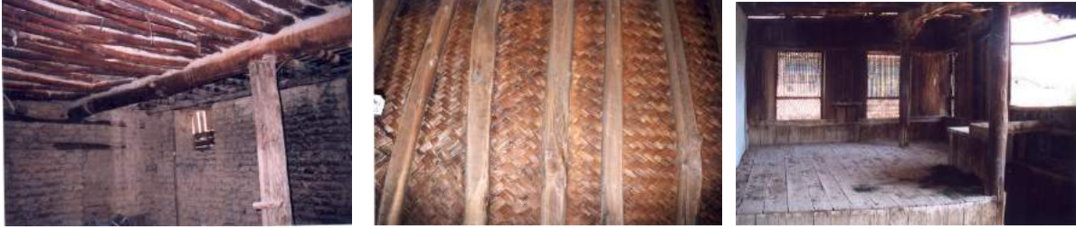
Şekil 24. ve Şekil 25. Tavan Döşeme örnekleri ve Hanayda Köşk Döşemesi (M.Yeğin Arşivi)
