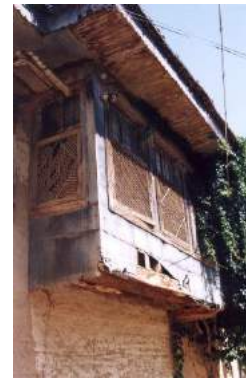
Şekil 22. ve Şekil 23. Cephede Çıkmalar ve Çinko Kaplama (M.Yeğin Arşivi)
