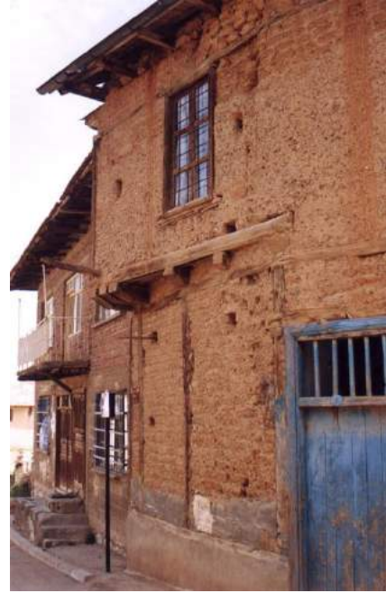
Şekil 18. ve Şekil 19. Yalvaç Konutlarında Taşıyıcı Duvar ve Farklı Çıkma Örnekleri
