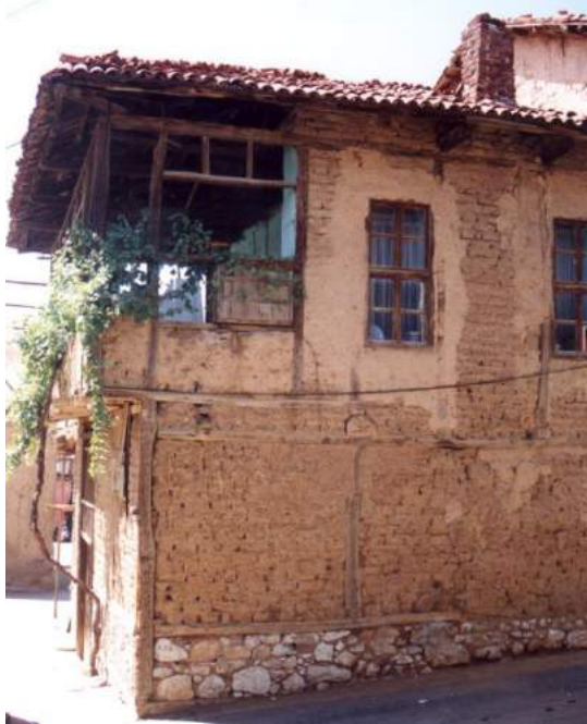
Şekil 18. ve Şekil 19. Yalvaç Konutlarında Taşıyıcı Duvar ve Farklı Çıkma Örnekleri
